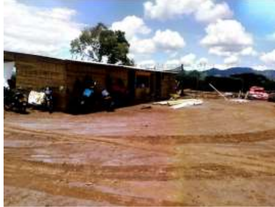
Fuente Propia. El Legado construcción de vivienda tipo en suelo rural
